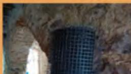
O sistema da S&P ARMO-System consiste na aplicação de argamassas especiais S&P ARMO-crete® e S&P ARMO-mur® projectadas sobre malhas de reforço em fibra de carbono S&P ARMO-mesh®. O sistema é usado no reforço estrutural em elementos de construção civil em geral, nomeadamente em alvenarias, muros, abóbadas e estruturas em betão.
